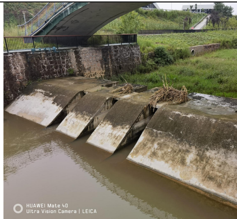
河道整治工程（溢流坝及格宾石笼河堤）
