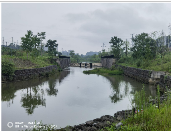
河道整治工程（溢流坝及格宾石笼河堤）
