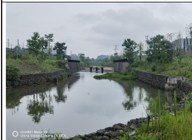
河道整治工程（溢流坝及格宾石笼河堤）
