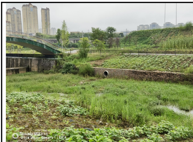
河道整治工程（穿堤涵管及人行拱桥）
