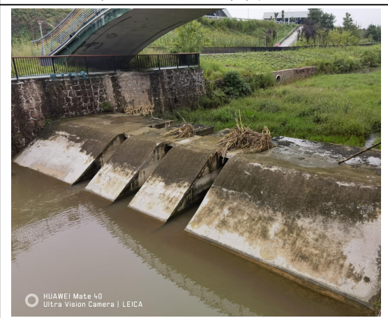
河道整治工程（溢流坝及格宾石笼河堤）
