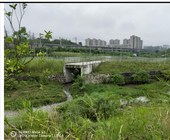
河道整治工程（穿堤涵洞）
